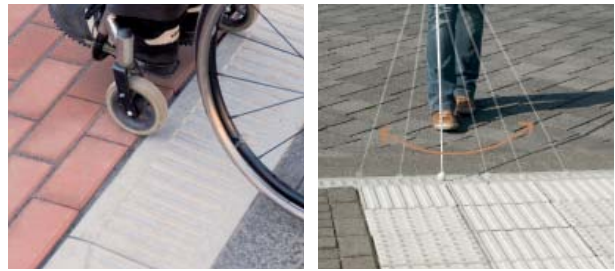
Der Rollbord: berollbar und sicher durch taktil erfassbare Oberfläche
